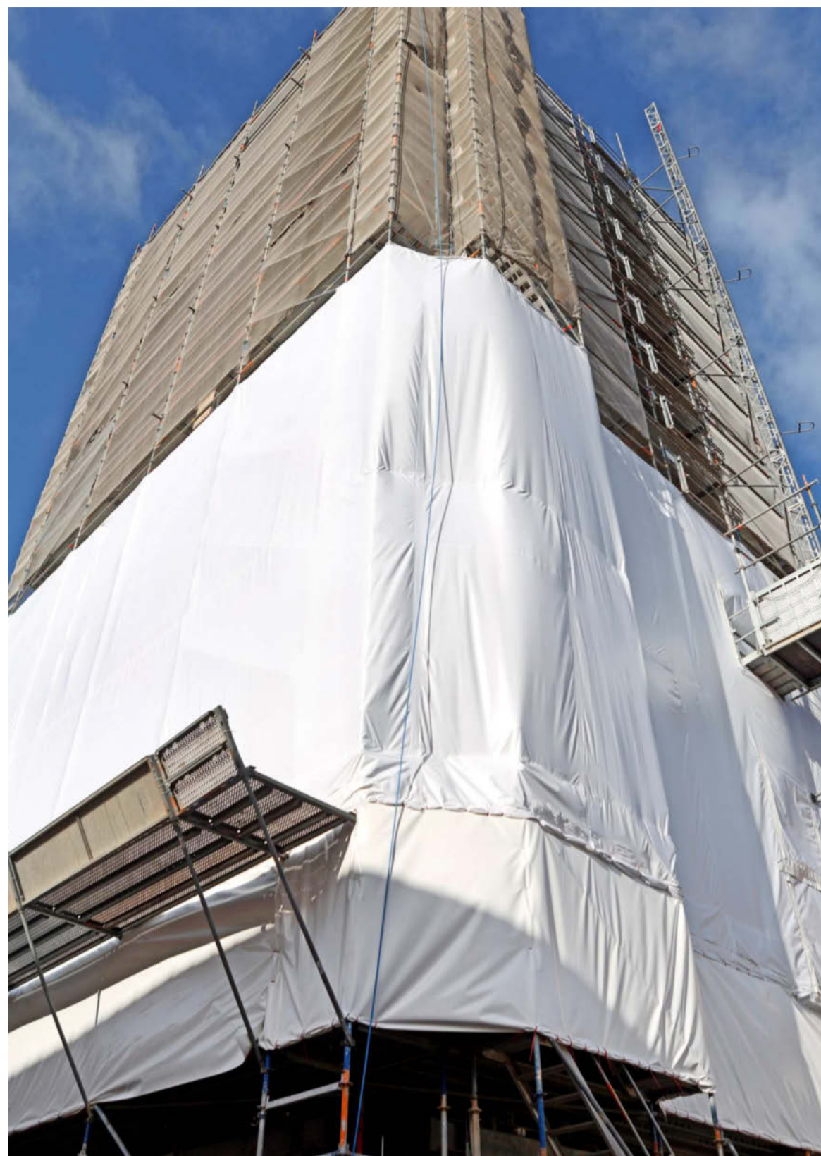
Um die Stabilisierung des Mauerwerks auch über die Wintermonate fortzuführen, wurde der Blaue Turm in eine Plane aus Gewebekunststoff gehüllt. Einige Fraktionen haben die Verhüllung wegen ökologischer Bedenken abgelehnt.
