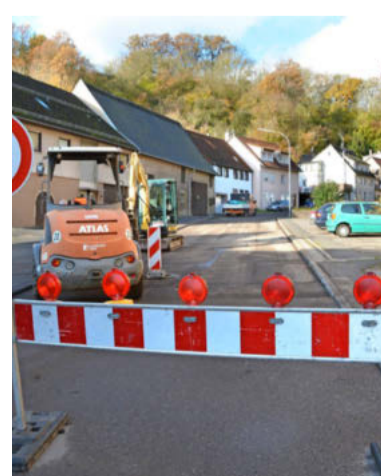
Die Ortsdurchfahrt Hauptstraße in Roigheim wird ausgebaut. Foto: Rudolf Landauer
