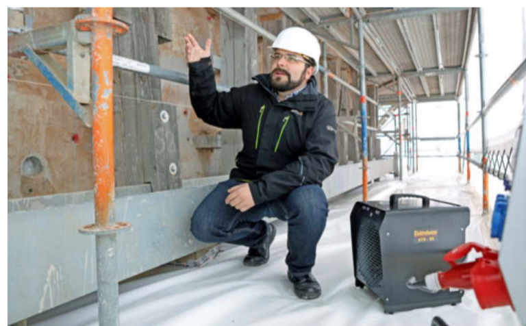
Verteilt über mehrere Gerüstlagen sorgen vier Heizlüfter dafür, dass die Temperatur des Mauerwerks nicht unter zehn Grad fällt. „Andernfalls wird der Mörtel nicht hart genug“, erklärt Architekt Stefan Schädel.
